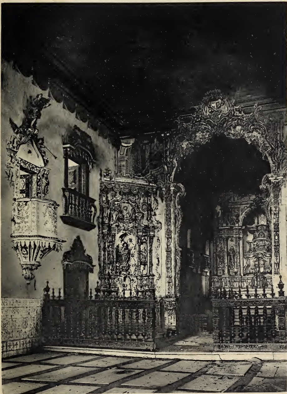
Vista interna do Convento de S. Antonio do Paraguassú. — Cachoeira. — Bahia.
